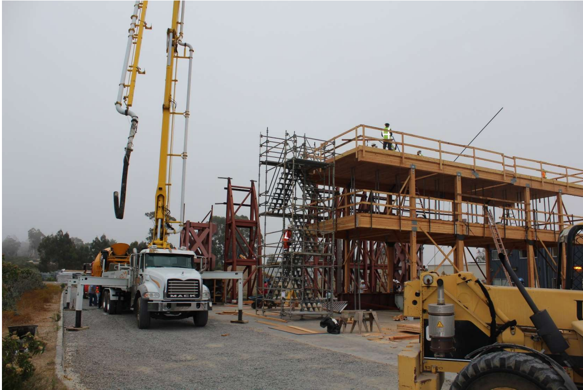
Pour Concrete, test strength....
